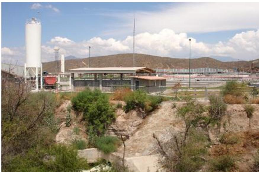
Figura 2. Silo de cal a la izquierda de las instalaciones para manejo de lodos en la PTAR Principal de Saltillo.
